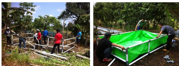
**Gambar 1.** Proses perakitan pembuatan kolam terpal ramah lingkungan
